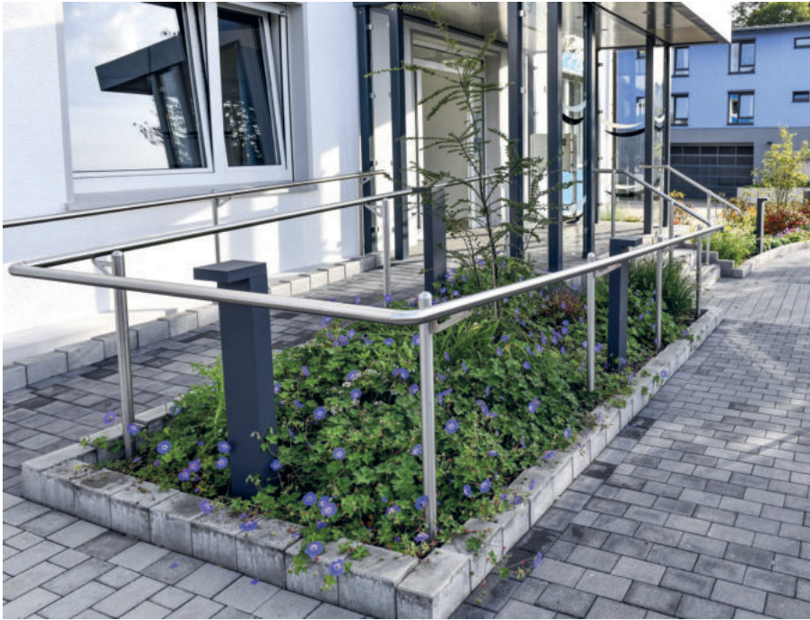
Kompetenzzentrum Barrierefreiheit Volmarstein (KBV) gGmbH der ESV, Eingangsbereich
